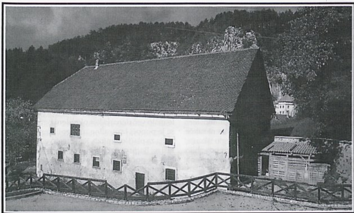
Grajski hlevi in kašča so bili Matevžev večednevno skrivališče (slika iz: Sapač, Grajske stavbe, str. 56).
