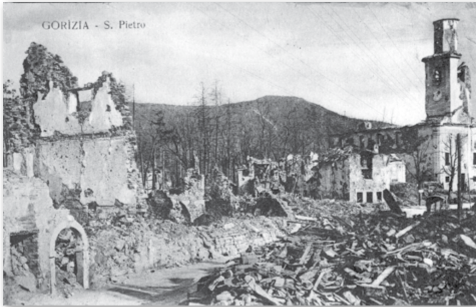
Slika 3: Šempeter pri Gorici - porušena glavni trg in cerkev Sv. Petra
