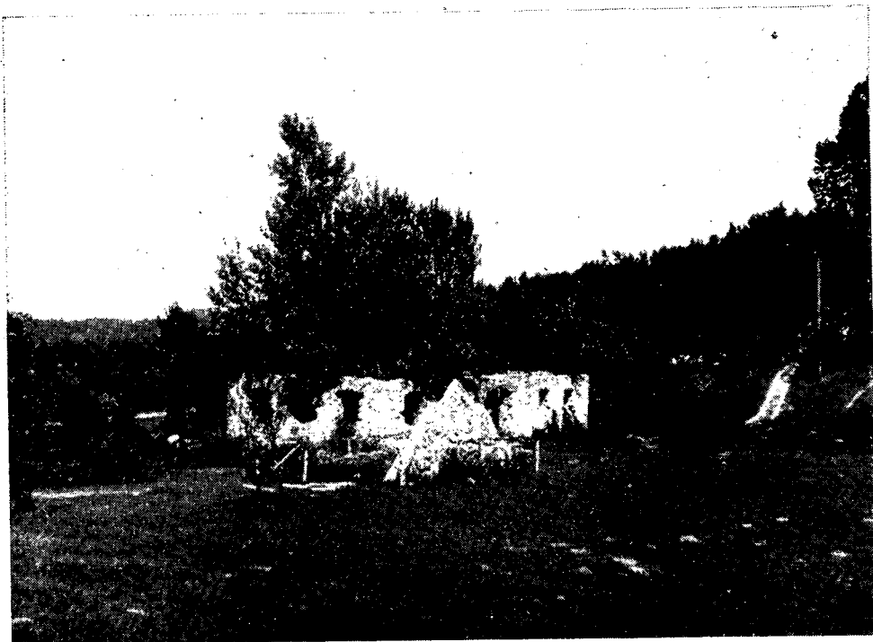
Slika 15: Pogled na požgano Plutovo hišo v Gornjih Lazah, kjer so v noči od 1. do 2. novembra 1941 končali borci I. Belokranjske čete. (Z jugozahoda; spredaj spomenik padlim borcem I. Belokranjske čete.) V šupi za hišo so spali v usodni noči borci te čete ob napadu Italijanov
