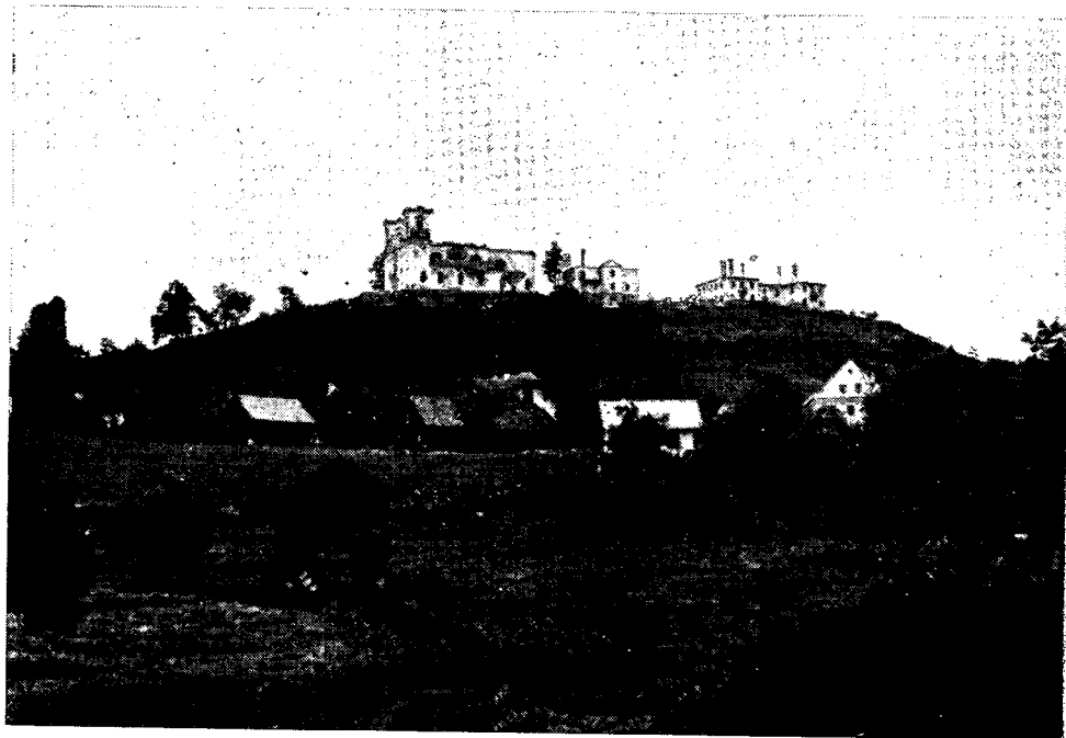
Slika 5: Ruševine cerkve, župnišča in prosvetnega doma na Zafari nad Žužemberkom — ostanki iz borb 14. maja 1944
