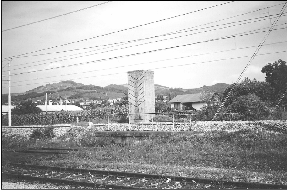
Betonski blok ob železnici Zidani Most-Zagreb v bližini železniške postaje Krško. Foto: Tomaž Teropšič, 2004. Fototeka PMB.
