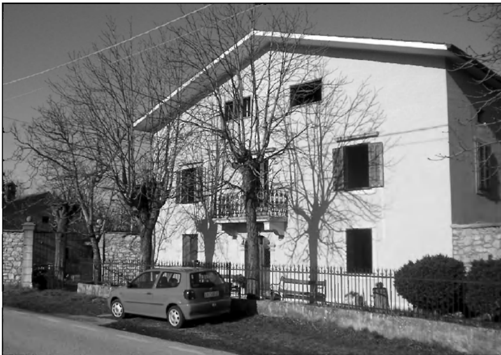
Prenovljena hiša pri Samatorci, kjer so Kalistrovi in Gorupovi preživljali proste dneve (foto: Mario Šušteršič, 2007).
