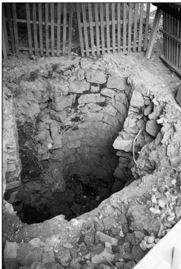
Ob prenovi hiše Štanjel 22a se je v podhodu pokazal podzemni vodni zbiralnik z jasno čitljivo zgradbo. Foto: E. Belingar, 2004.
