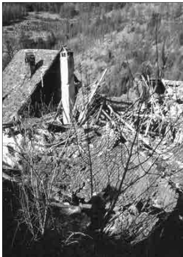
Sesuta streha nad veznim traktom in osrednjim delom severnega trakta gradu Lemberg (Igor Sapač, 1999).
