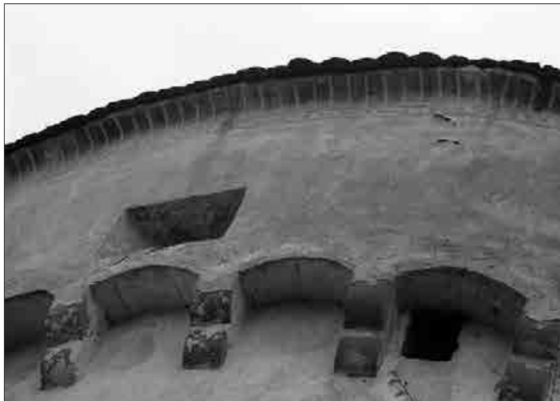
Detajl obrambnega konzolnega venca velike ronделе na gradu Lemberg z arhitekturno poslikavo pod napuščem (Igor Sapač, 2006).
