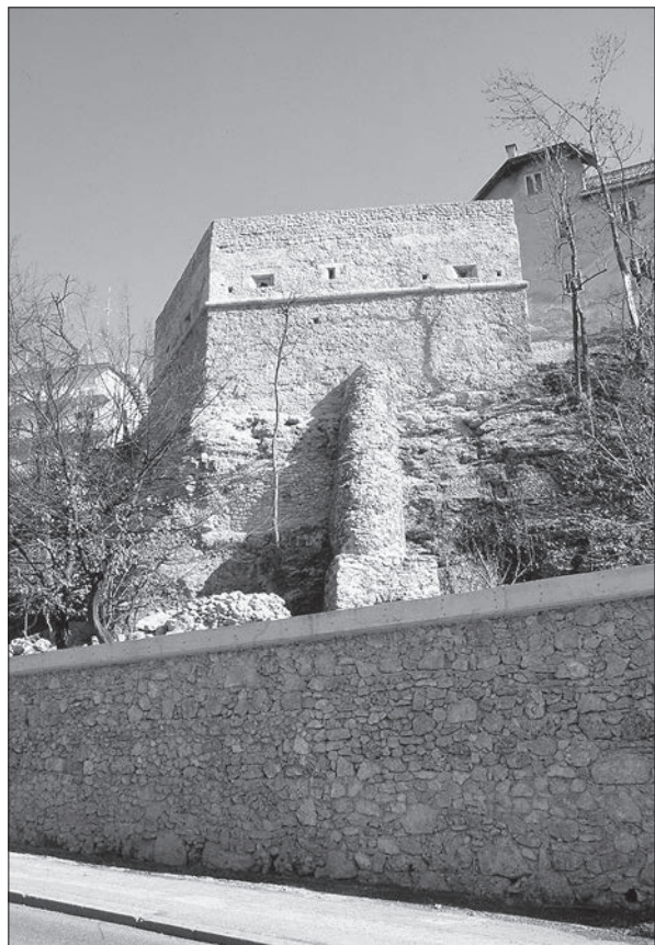
Slika 11: Pogled na stolp Škrlovec prek mlinskega kanala in lokacije nekdanjega črpališča med prenovo leta 1994. Sign. 46014 (fototeka ZVKDS OE Kranj). Spodnjemu delu stolpa je bila do prenove stolpa leta 1994 prizidana vertikalna kineta s starim vodovodom.
