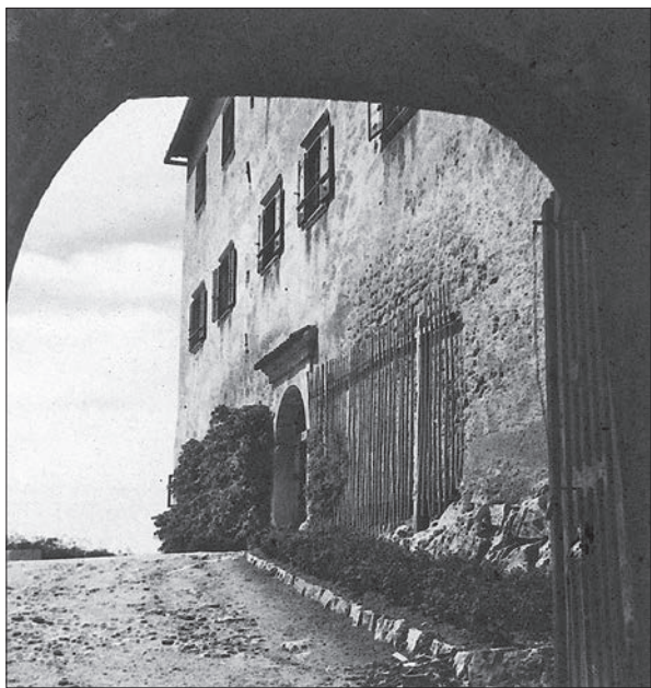
Slika 3: Zahodna stena gradu Hmeljnik z vhodom v grajsko stavbo, ok. 1930 (zasebni arhiv).
