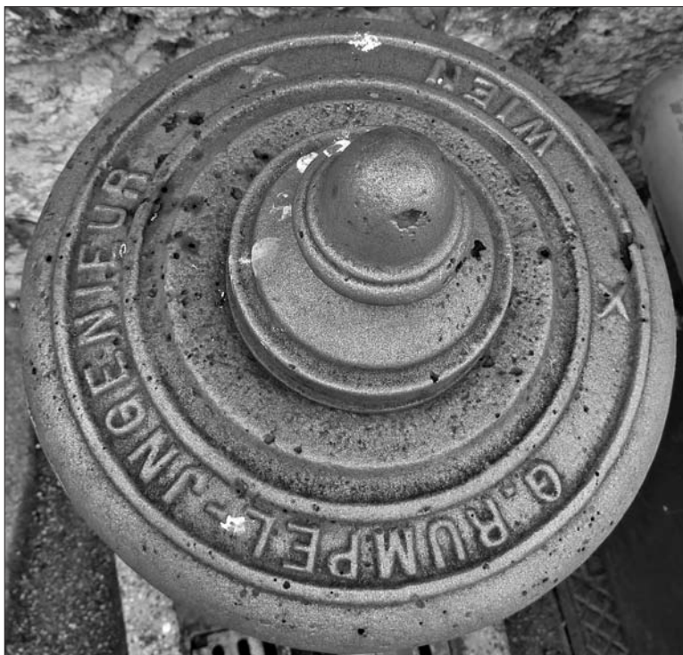
Novo mesto, Kapitelski trg, pokrov ventilnega pitnika s signaturo izvajalca del vodovodne napeljave inž. G. Rumpla (foto: Simona Kermavnar).
