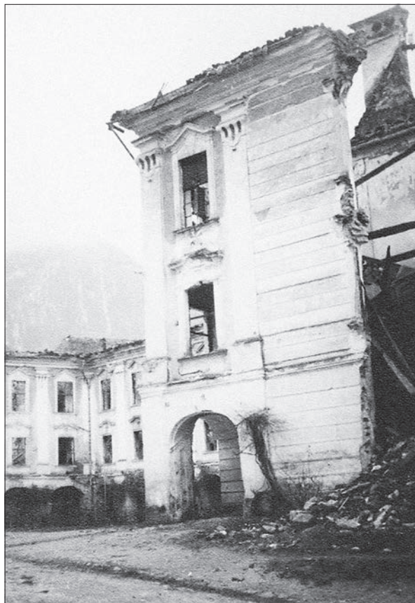
V bojih uničene in poškodovane stavbe v Gornjem Gradu (hrani Muzej novejšje zgodovine Celje).
