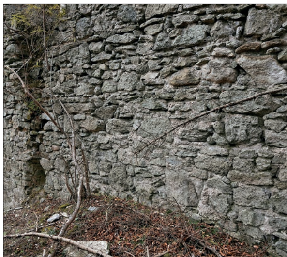
Pogleda na značilno kompartmentno strukturo zidave iz 14. stoletja na jugozahodni (levo) in jugovzhodni stranici (desno) gotskega stolpa gradu Rudenek (foto: Igor Sapač, 2024).
