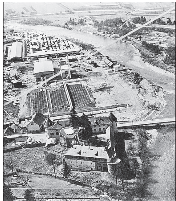
Pogled na deloma obnovljeni grajski kompleks iz zraka z vzhodne strani okoli leta 1970. V ozadju je vidno območje lesnopredelovalnega podjetja Glin (INDOK).
