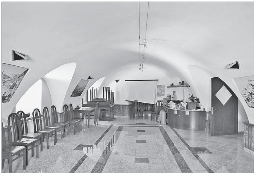
Banjasto obokani prostor iz prve polovice 16. stoletja v kletni etaži vzhodnega trakta (foto: Igor Sapač, 2024).
