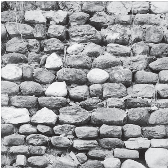
Struktura romanske zidave na jugovzhodni strani obodnega zidovja jedra gradu Vrbovec okoli leta 1970 (foto: Ivan Stopar, iz zasebne dokumentacije Igorja Sapača).
