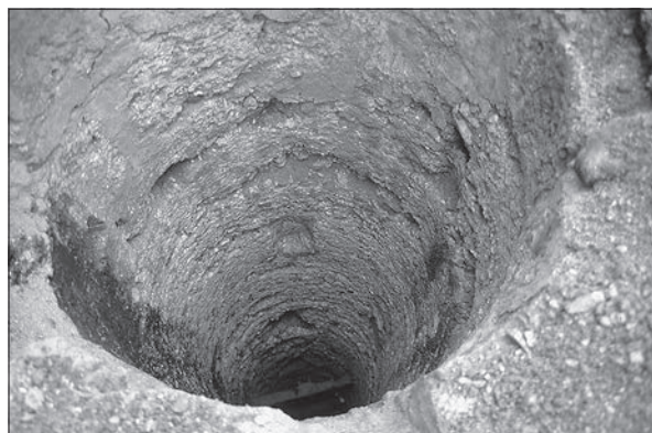
Slika 17: Jašek »Haynejevega« vodnjaka. Sign. 69309 (fototeka ZVKDS OE Kranj).
