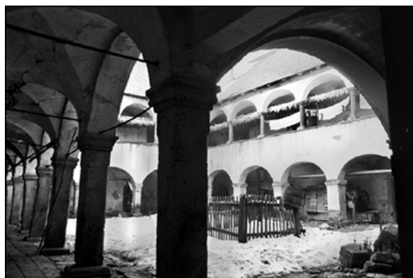
Arkadno dvorišče leta 1971 (fototeka ZVKDS, OE Kranj).
