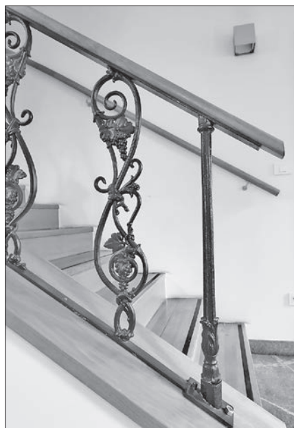
Slika 15: Litoželezna stopniščna ograja v Mestni knjižnici Grosuplje, detajl (foto: Simona Kermavnar).
