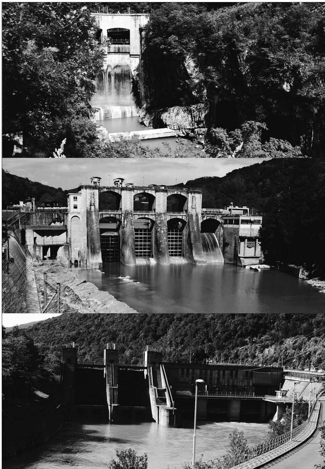
Pregrade za potrebe hidroenergetskih objektov na Soči – zgoraj: pregrada Podselja, zgrajena leta 1939 za potrebe HE Doblar; sredina: pregrada Ajba, zgrajena leta 1940 za potrebe HE Plave; spodaj: pregrada Solkan, zgrajena leta 1984 za potrebe HE Solkan (fotograf: Matija Zorn).
