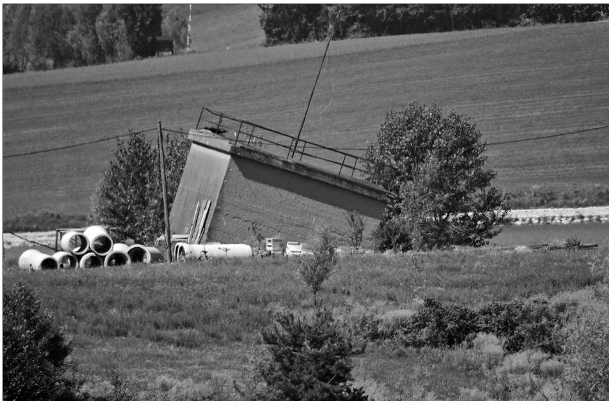
Slika 12: Ugreznjeni ostanki premogovniškega objekta na Prelogah (foto: Matija Zorn).
