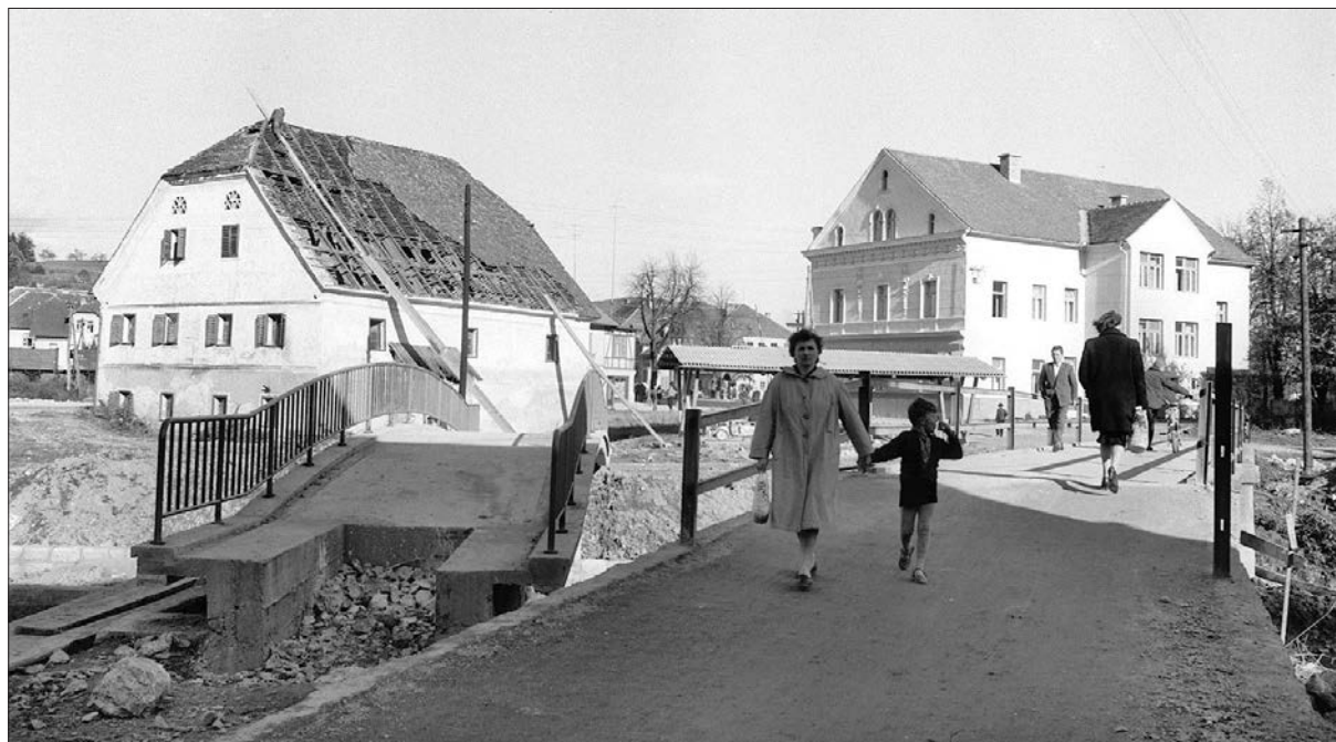
Regulacija Pake in izgradnja novega mostu. Pričela se je rušitev Brišnikovega mlina (Betonski most za pešce čez Pako, avtor fotografije Jože Gal, 27. oktober 1960, https://commons.wikimedia.org/wiki/ ).
