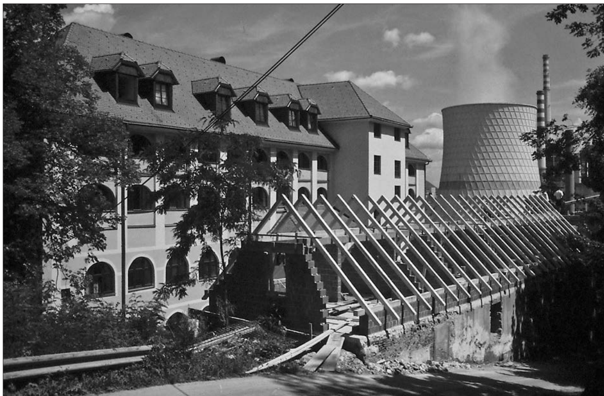
Pogled na dvorec Turn z zahodne strani po zaključku prenove glavnega trakta in med prenovo stranskega trakta (foto: Igor Sapač, julij 1999).
