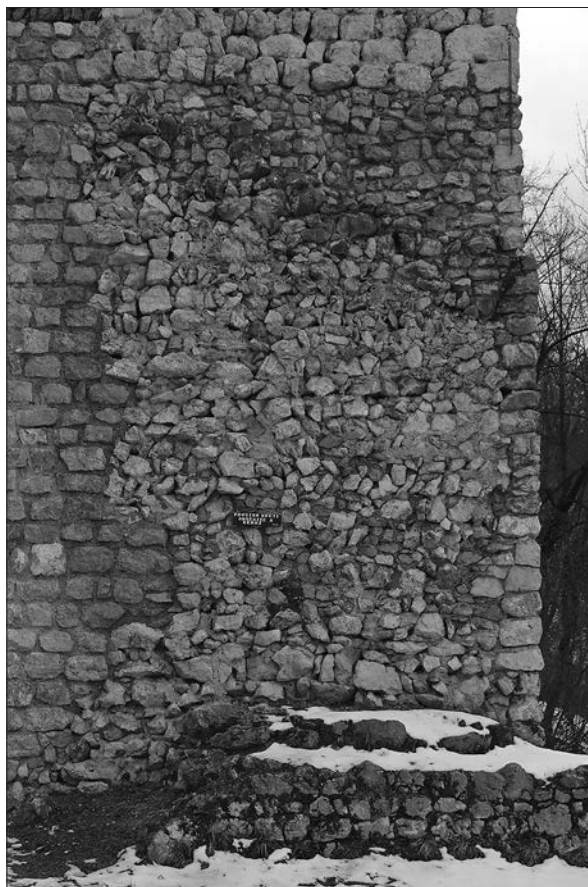
Pravilna struktura zidave zgornjega dela zahodne stene na zunanjsčini glavnega stolpa (levo) in povsem drugačna struktura zidave v spodnjem delu vzhodne stene (desno), kjer je bil stolp naslonjen na starejše obodno obzidje (foto: Igor Sapač, 2021).
