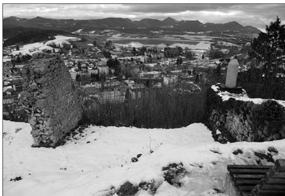
Ostanki manjšega poslopja na vzhodni strani grajskega kompleksa, ki so ga postavili nad porušeno starejšo stavbo (foto: Igor Sapač, 2021).
