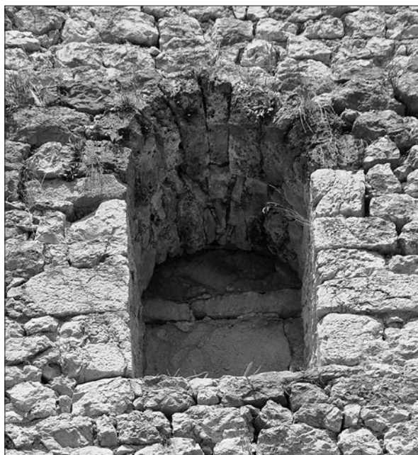
Stranišče na severni steni v nekdanjem tretjem nadstropju glavnega stolpa šoštanjkega gradu z zunanje in notranje strani (foto: Igor Sapač, 2021).
