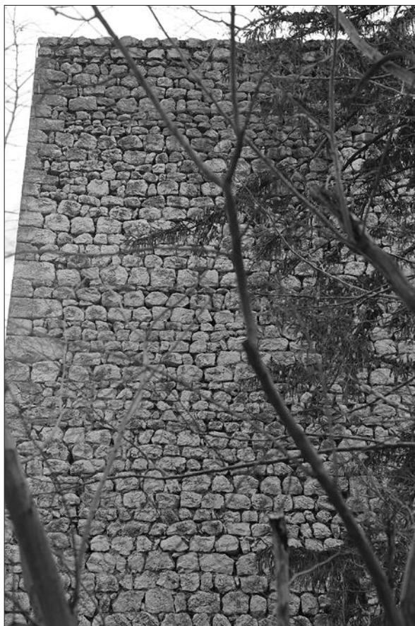
Pravilna struktura zidave zgornjega dela zahodne stene na zunanjsčini glavnega stolpa (levo) in povsem drugačna struktura zidave v spodnjem delu vzhodne stene (desno), kjer je bil stolp naslonjen na starejše obodno obzidje (foto: Igor Sapač, 2021).
