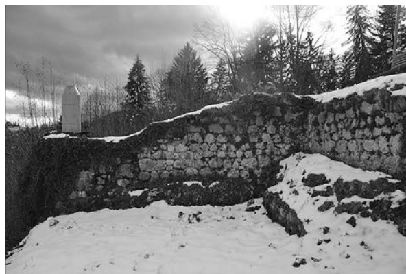
Zidovje na vzhodni strani grajskega kompleksa je pozidano nad starejšim debelejšim zidom, ki je najverjetneje pripadal prvotni grajski bivalni stavbi, porušeni med fajdo okoli leta 1438 (foto: Igor Sapač, 2021).
