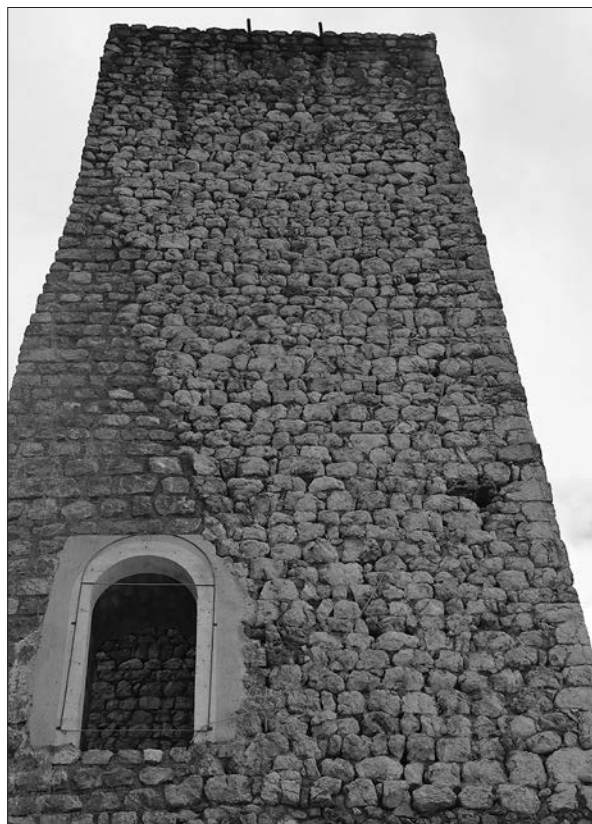
Primerjava strukture zidave na zunanjsčini glavnega stolpa (levo, vzhodna stena) in v njegovi nekdanji notranjsčini (desno, severna stena). Nadomestni portal iz armiranega betona je nastal med sanacijskimi deli leta 1998 (foto: Igor Sapač, 2021).
