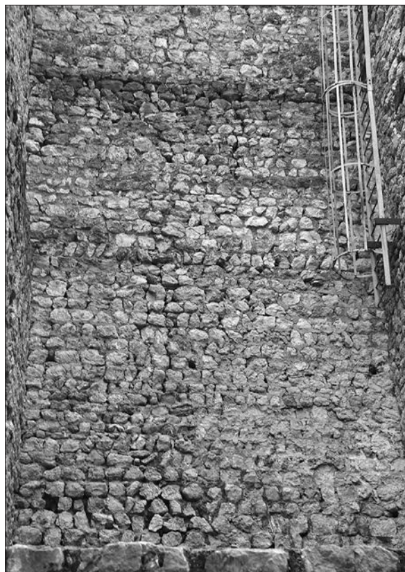
Primerjava strukture zidave na zunanjsčini glavnega stolpa (levo, vzhodna stena) in v njegovi nekdanji notranjsčini (desno, severna stena). Nadomestni portal iz armiranega betona je nastal med sanacijskimi deli leta 1998 (foto: Igor Sapač, 2021).
