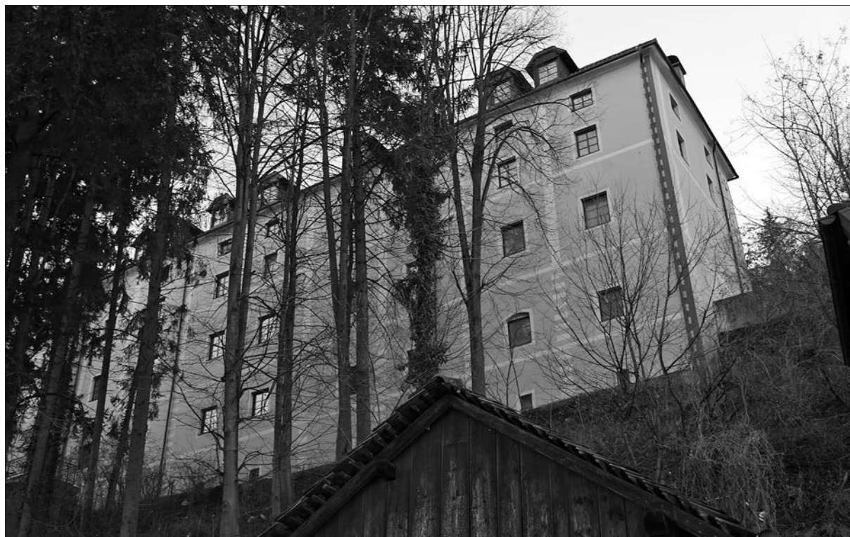
Mogočna stavbna gmota nekdane kašče iz 17. stoletja. Pogled s severne strani (foto: Igor Sapač, 2016).
