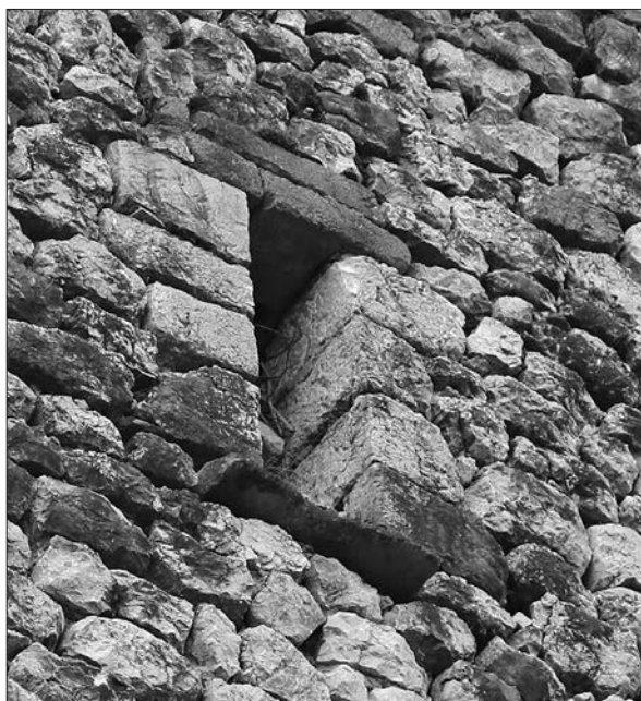
Stranišče na severni steni v nekdanjem tretjem nadstropju glavnega stolpa šoštanjkega gradu z zunanje in notranje strani (foto: Igor Sapač, 2021).
