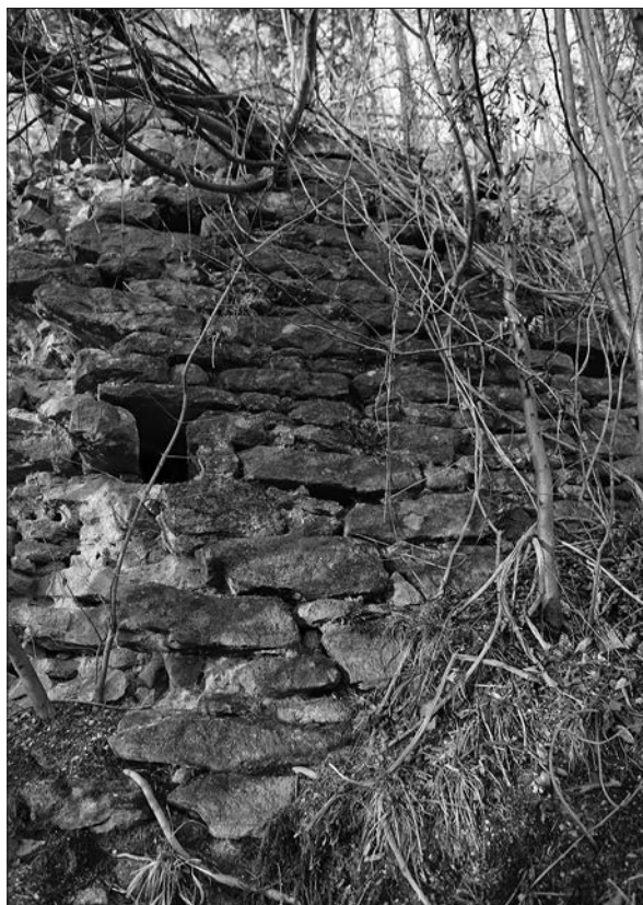
Ostane manjše stolpičaste gradnje – domnevno nekdanjega grajskega stranišča – ob skalni steni na južni strani nekdanjega gradu (foto: Igor Sapač, 2016).
