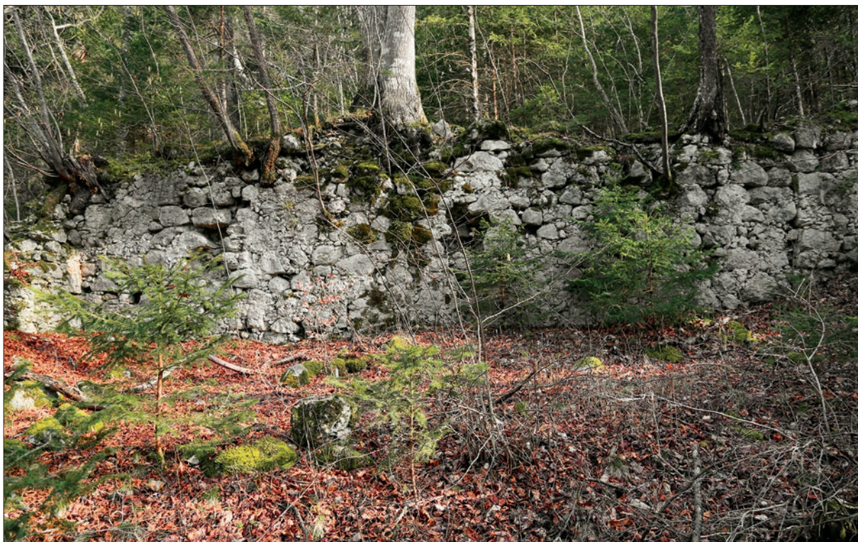
Pogled na razvaljeno notranjo steno nekdanje kašče gradu Glanz oziroma (Novi) Gutenberg. Na desni strani stene je vidna cezura, ki kaže obseg prvotne stavbe in mlajši prizidek (foto: Igor Sapač, 2020).
