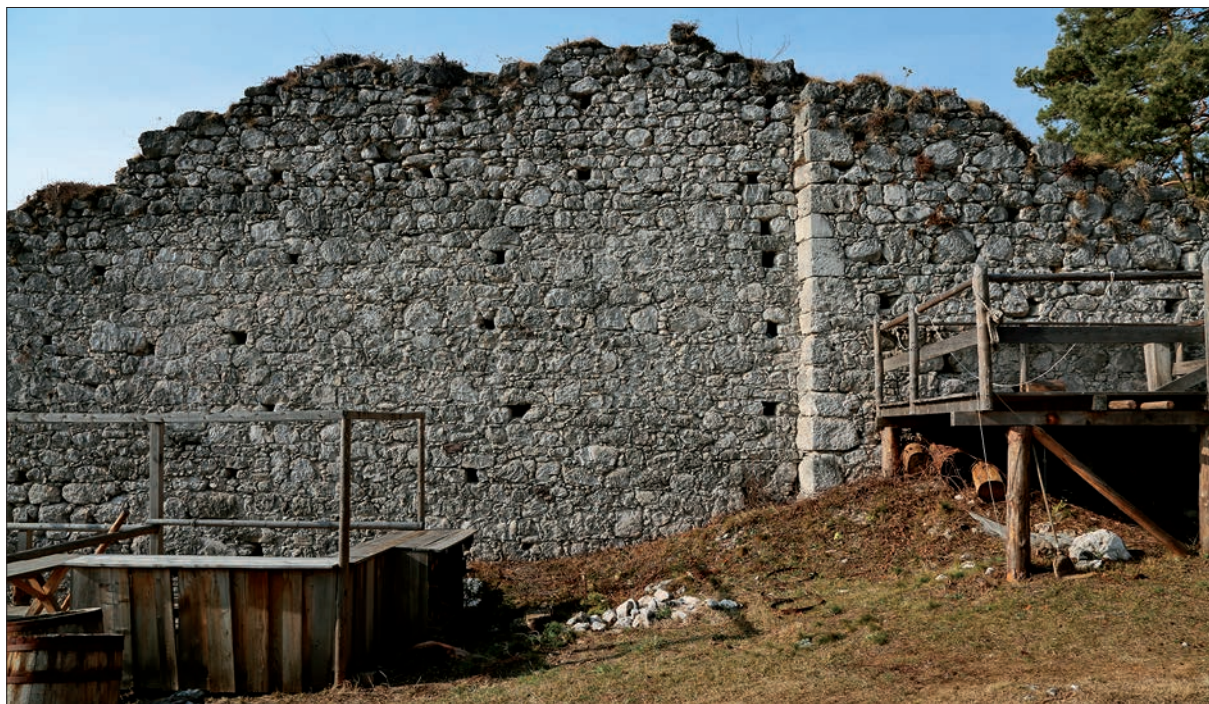
Pogled na dvoriščno stran severnega dela zahodne stranice obodnega obzidja zgornjega dela gradu z vidnim stopničastim zamikom zidnega plašča (foto: Igor Sapač, 2020).
