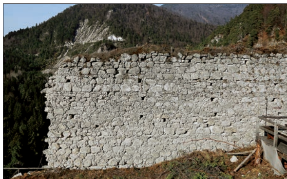
Struktura poznosrednjeveške kamnite zidave na dvoriščni strani zahodne stranice obodnega obzidja zgornjega dela gradu (foto: Igor Sapač, 2020).
